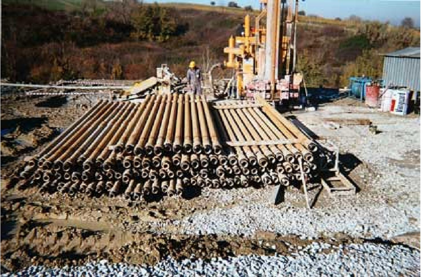
Questa tecnica trova applicazione diffusa in quanto idonea ad affrontare terreni a conformazione sia alluvionale che rocciosa, ed è particolarmente indicata per diametri medio-piccoli (da 6" a 17"1/2, ossia da 152 a 444 mm) e profondità anche elevate.
