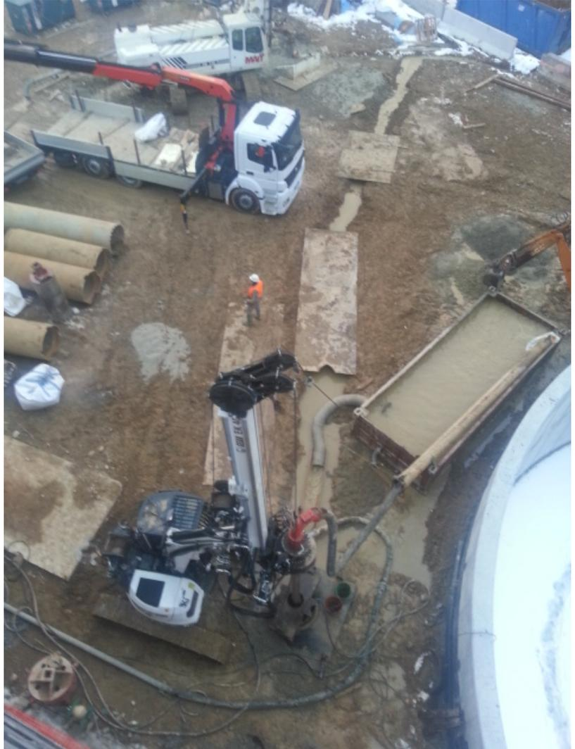
Il fango utilizzato, per le modalità proprie del sistema descritto, può anche essere formato da sola acqua o da bentonite a bassa viscosità e densità, con vantaggi finali per le fasi di spurgo e sviluppo dei pozzi e di smaltimento dei residui di lavorazione.
